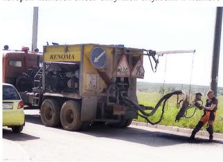
гранитного щебня. Как говорят, использование этой смеси позволяет обеспечить длительную эксплуатацию отремонтированного участка, так как после проведения работ эмульсия окончательно высыхает, пломбируя выбоину. Как сказал оператор этого удивительного агрегата для ямочного ремонта, участок дороги полностью пригоден для полноценной эксплуатации уже через 30 минут.
